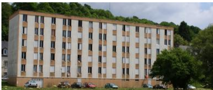
L'office départemental de l'Habitat a cédé, il y a peu, à Blavet Habitat les « barres » Kesler et Edouard-Vaillant, construites dans les années 70, à Malachappe : quel est leur avenir ?
